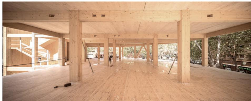
de hormigón armado. Sobre rasante, se soluciona mediante estructura de madera con forjados tipo CLT y con pilares y vigas de madera laminada.
